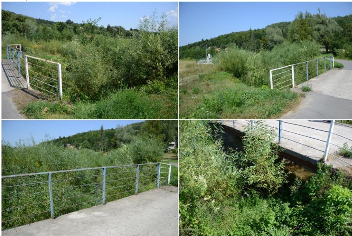
Fot. 29. Most i koryto rzeki Rzepianka w punkcie P7_Rzepianka
