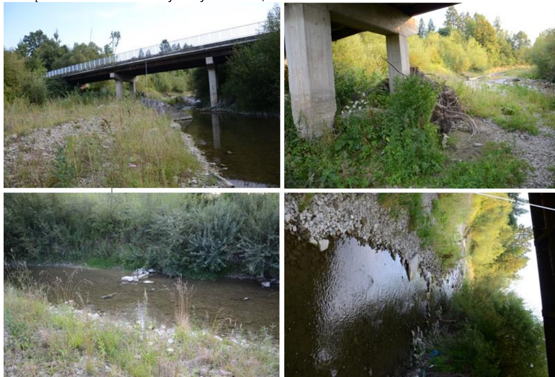
Fot. 24. Most i koryto rzeki Mostysza w punkcie P2_Mostysza
