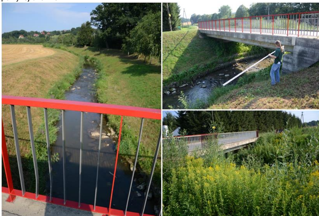
Fot. 28. Most i koryto rzeki Kąśnianka w punkcie P6_Kąśnianka
