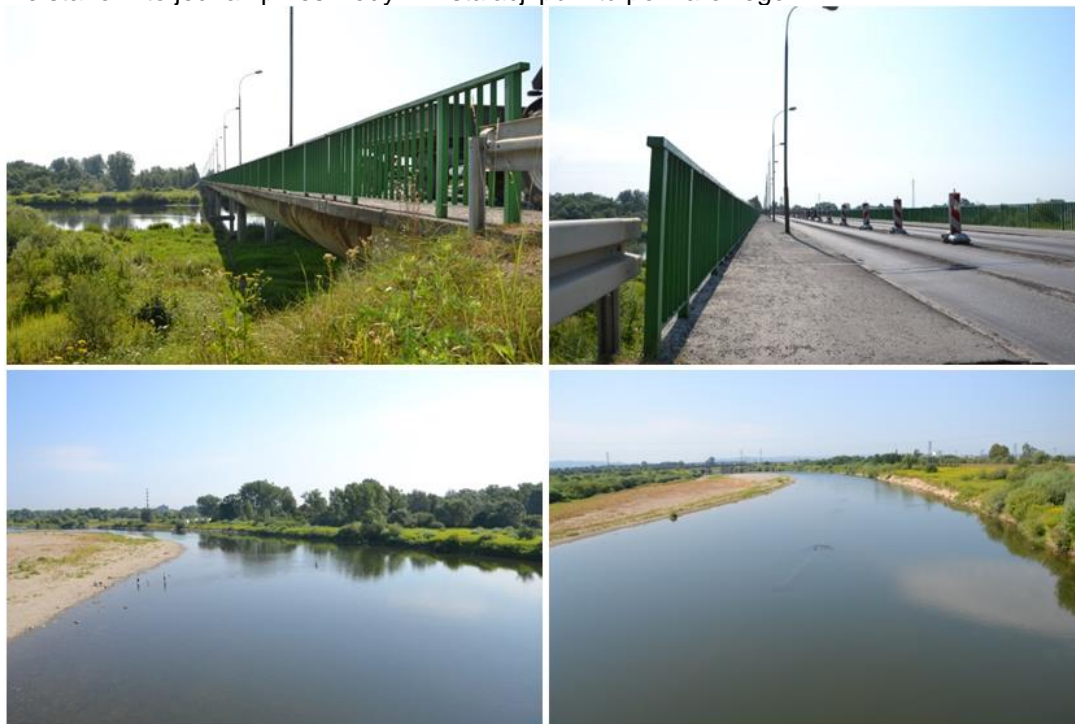
Fot. 32. Most i koryto rzeki Dunajec w punkcie P10 Dunajec.
